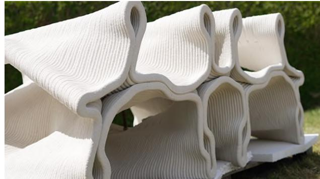
Pour des structures de type passerelle, les pièces imprimées sont conçues comme des voussoirs de pont, puis assemblées par post-tension pour former une ossature porteuse monolithique. Cette innovation, comparée aux techniques existantes, dévoile une ligne architecturale unique et biomorphique.
