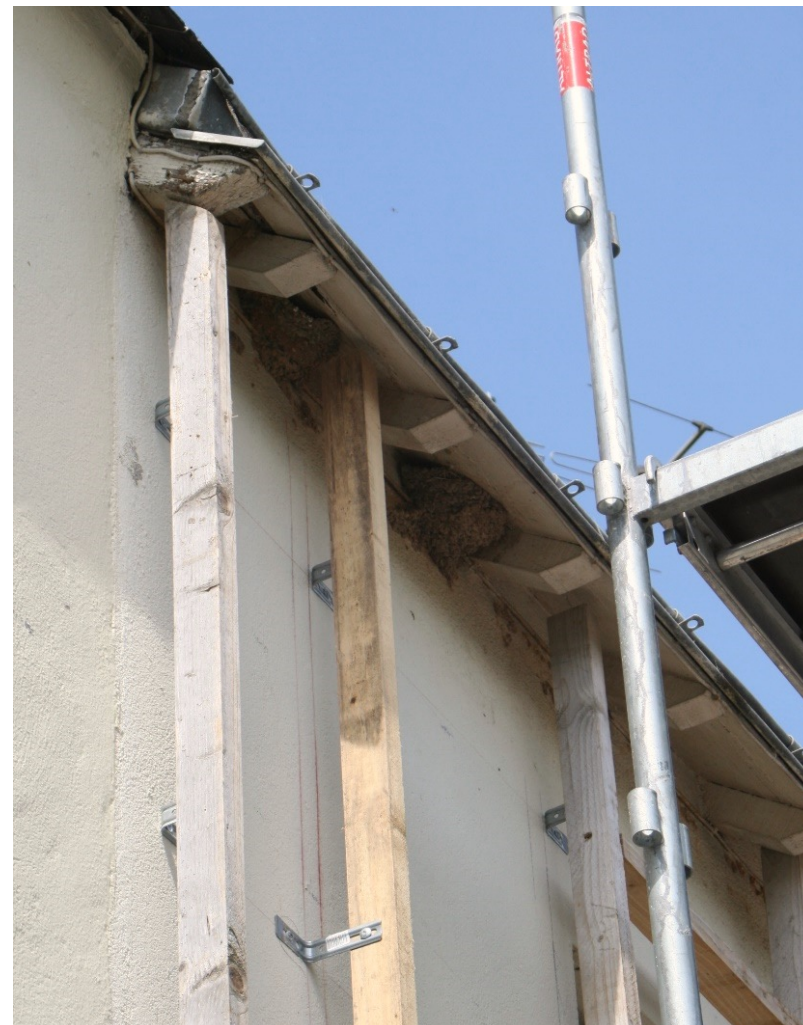
La pose d'isolation thermique par l'extérieur ou de bardage entre en conflit avec la position des nids d'hirondelles
