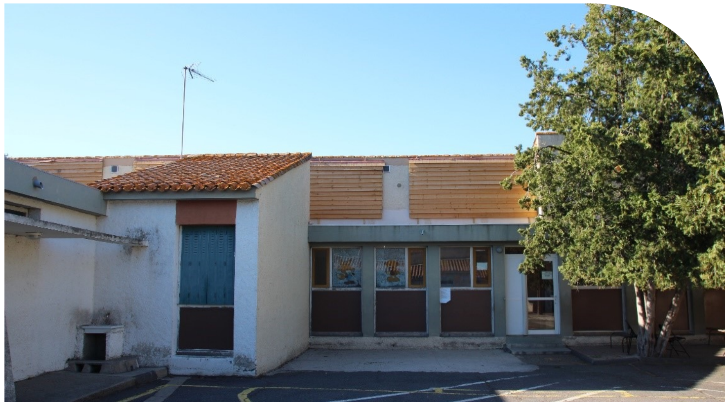
Pose d'un bardage sur une école pour créer des gîtes de repos/transit pour une colonie de Pipistrelles pygmées © Camille Montegu – LPO
