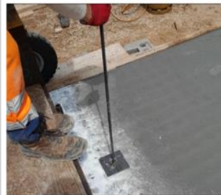
Figure 17 : Photos illustrant un des moyens de contrôle de l'épaisseur de la couche BFUP
