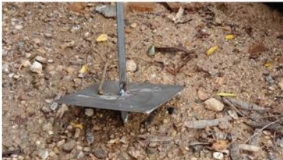
Figure 17 : Photos illustrant un des moyens de contrôle de l'épaisseur de la couche BFUP
