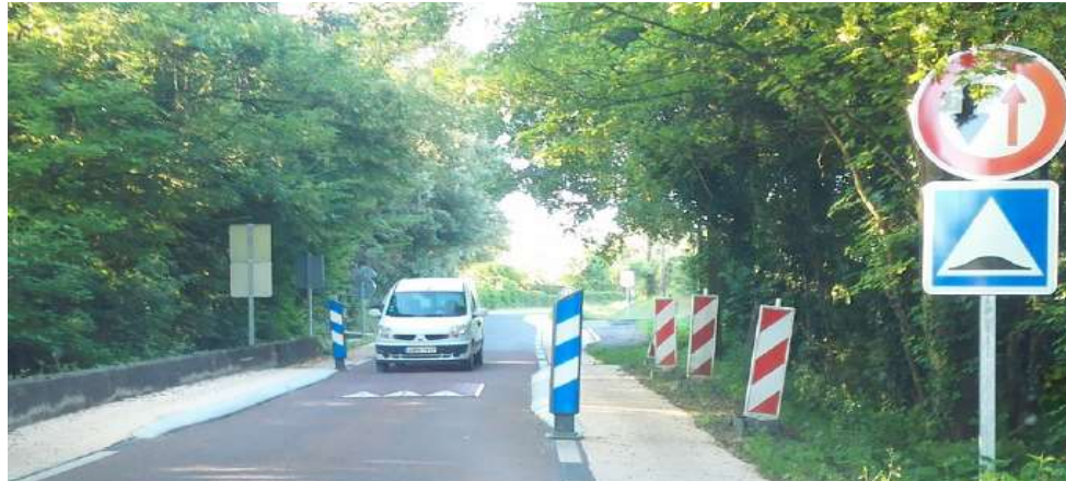
écluses et limitation à 30 km/h dans les virages
