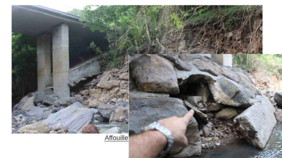
Affouillement de 1.5m de hauteur au droit de la semelle de la pile (en rive droite)
