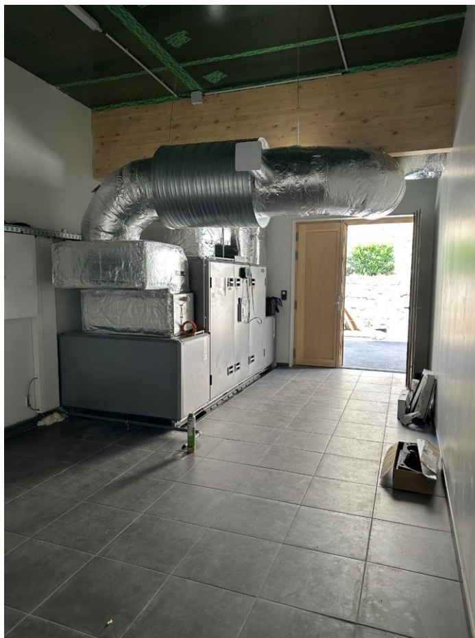
Centrale de traitement d'air
