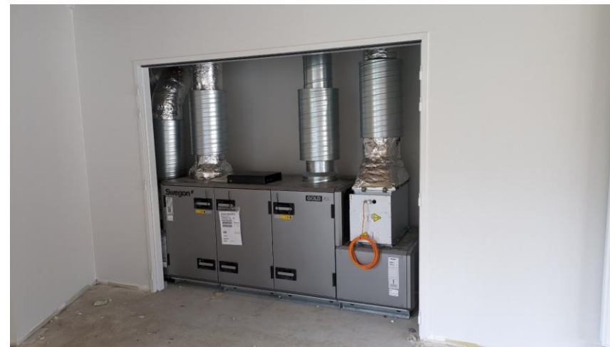
Centrale de traitement d'air
