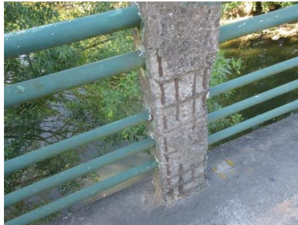
Epaufures sur les poteaux béton des garde-corps
