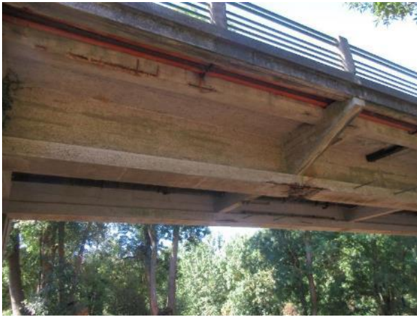
Epaufures béton en intrados
