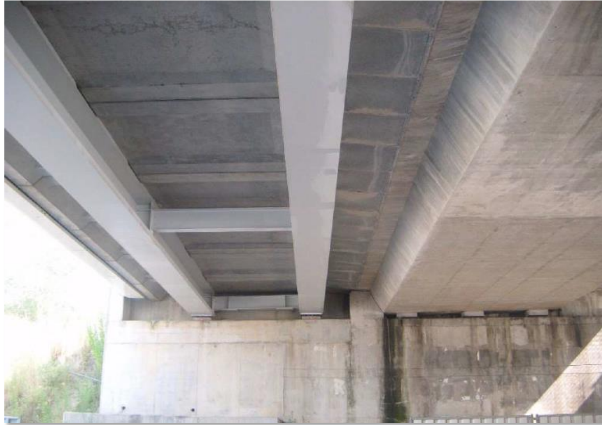
Elargissement en Aval et en Amont par tabliers mixtes à entretoises
