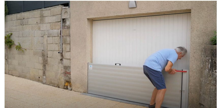
Installation d'un batardeau – Entente Oise Aisne – septembre 2022
