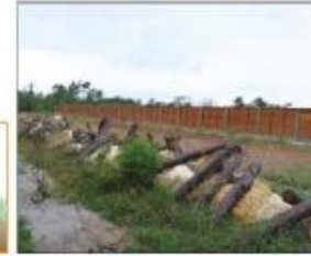
Figure n°5 : Andain de rochers et de rondins de bois sur l'écopont de l'ATO. Source : Cerema et LPO Drôme.
