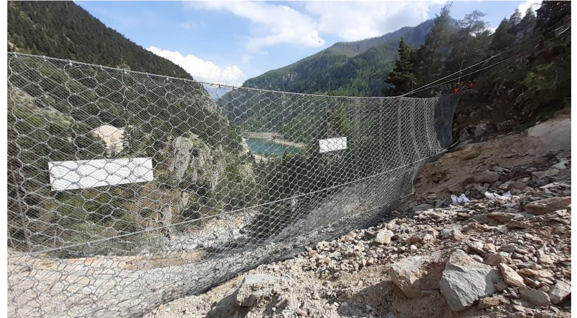
Mise en œuvre d'un écran souple pare-blocs provisoire de 5000 kJ
