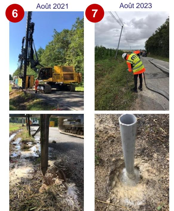
6 Stabilisation physico-chimique du sol sous chaussée par injection du RemediaClay®
