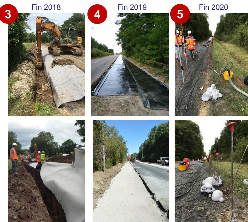
3 Étanchéification verticale par encapsulage avec une géomembrane
