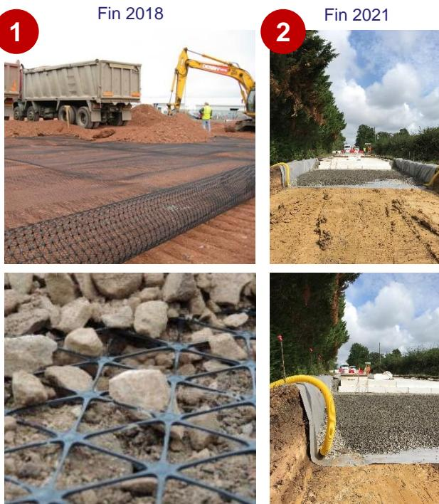
1 Stabilisation mécanique de la couche porteuse par deux lits de géogrille triaxiale TriAx®
