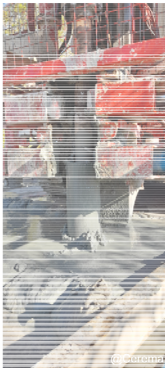
Forage en cours d'exécution avec injection de mortier
