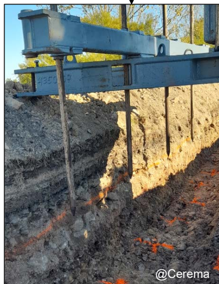
Vérinage des pointes d'injection (si possible)
