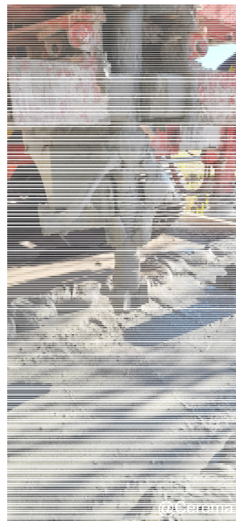
Sortie de l'outil après foration et injection
