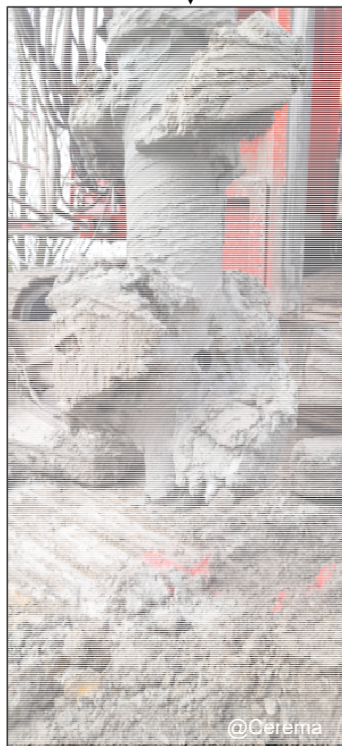
Tête de forage et tarière Ø 80cm pour réalisation des colonnes sécantes
