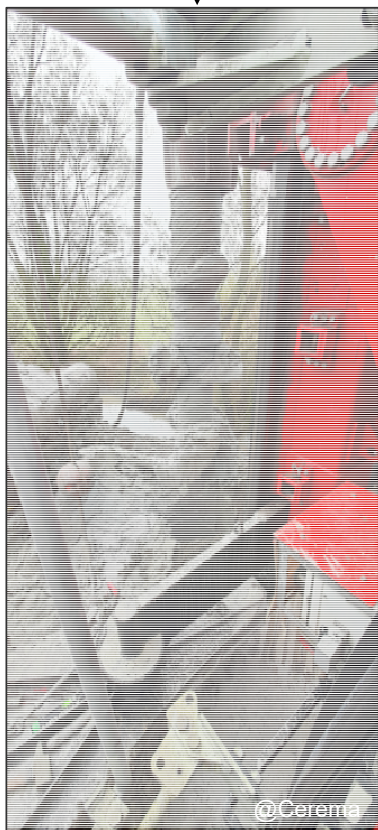
Tête de forage et tarière Ø 80cm pour réalisation des colonnes sécantes
