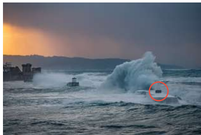
Bloc de 50 t sur la digue de l'Artha
