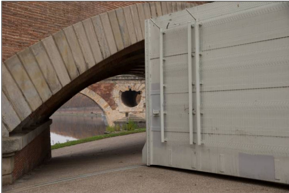
Watertight door La Garonnette
