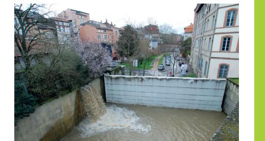
L'eau de la Garonne, en cas de crue, est susceptible de remonter dans les canalisations d'eaux pluviales et d'inonder ainsi des points bas de la ville. **Des vannes et des pompes** ont été installées pour éviter ce phénomène. Autant, de dispositifs à fermer et actionner au fur et à mesure de la montée des eaux.
