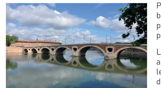
Pour résister à ces assauts, le Pont Neuf est bâti sur **sept arches irrégulières**, chaque pile étant précédée d'un avant bœc ① et percée d'un dégueuloir (ou ouïes) ②.
