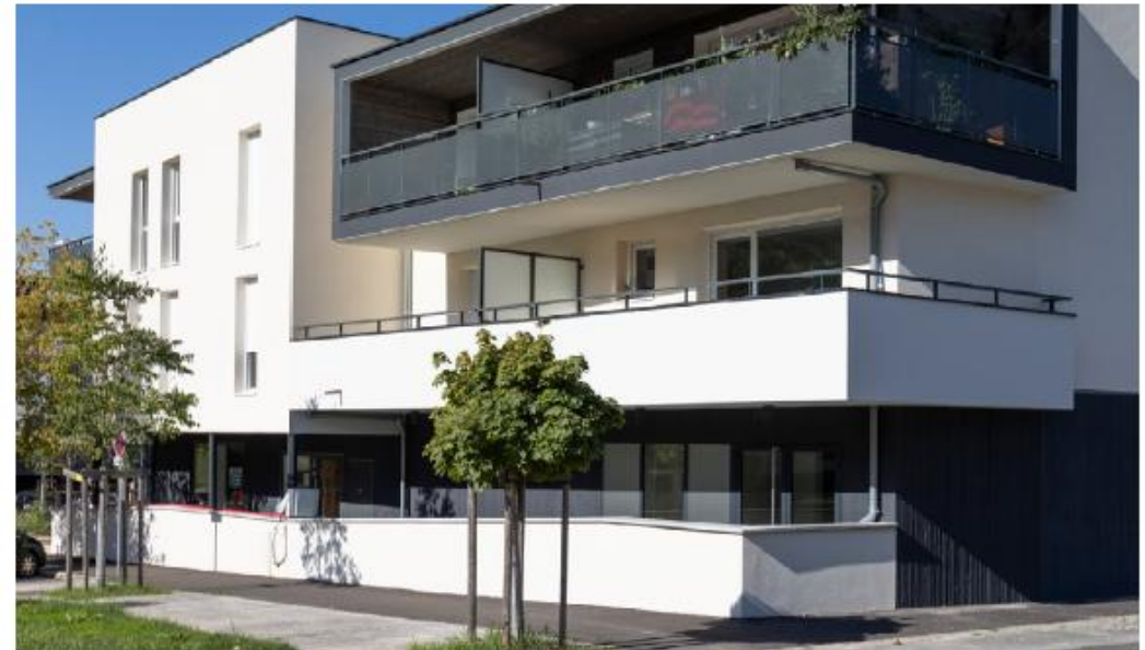
Murs déflecteur permet de canaliser les écoulements afin de protéger les ouvertures
