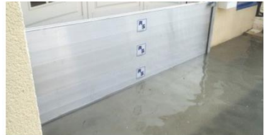
Batardeau en protection individuelle EPTBMM
