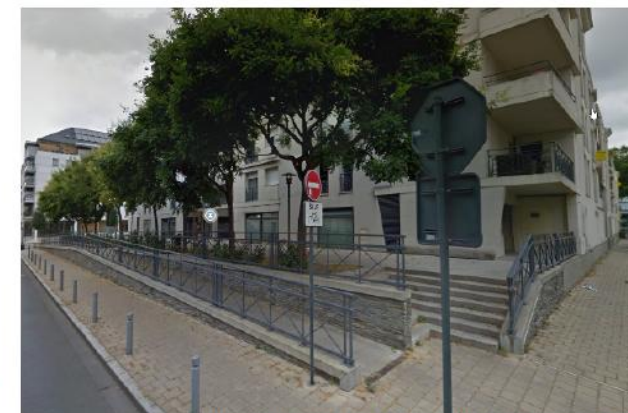
Intégration de la rampe dans l'espace public Rue du Port de l'Ancre à Angers
