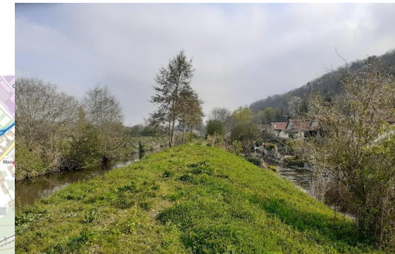
Canal usinier perché à gauche et bras de l'Iton en pied de digue côté bâti
