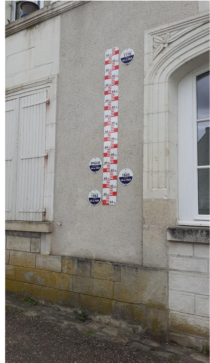
Repères de crue à Reignac-sur-Indre – source: Cerema 2024
