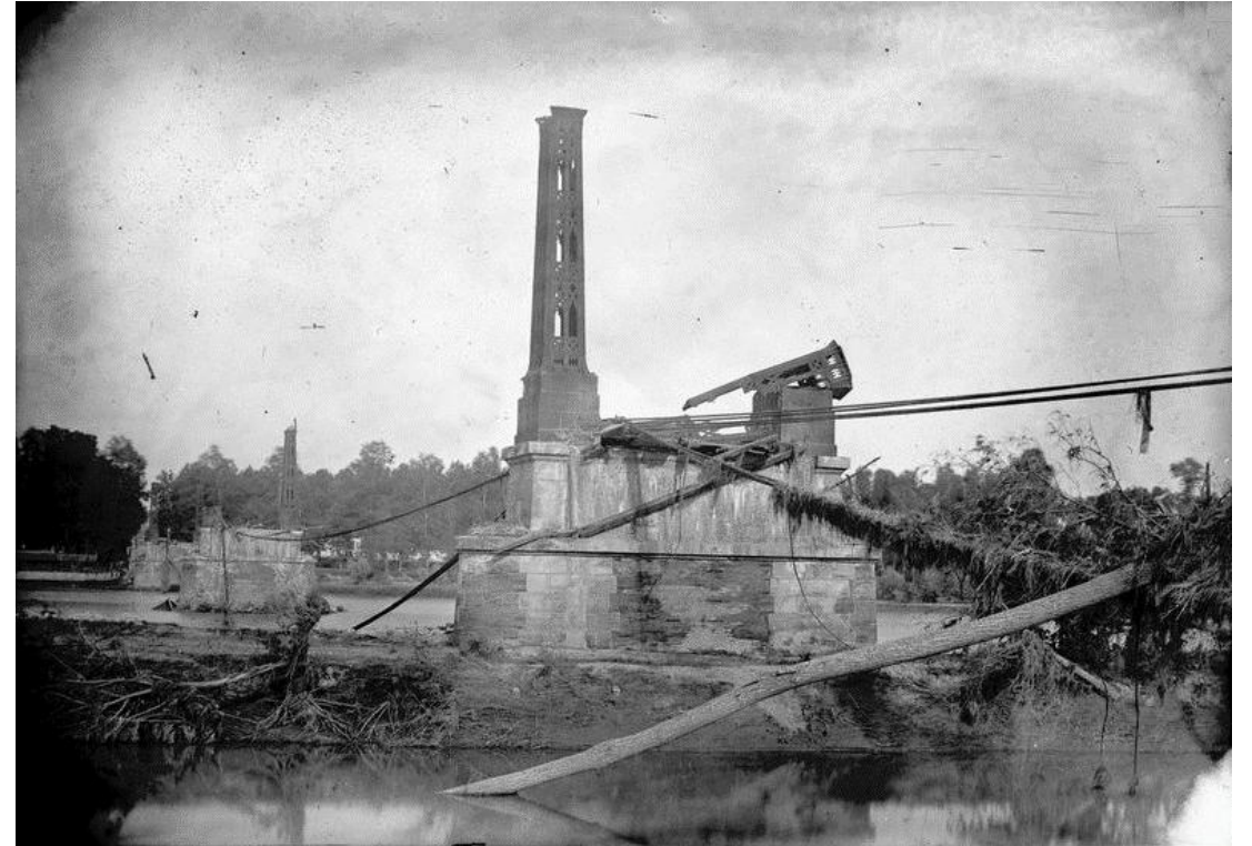
Piles du pont Saint-Michel – Crue de 1875 – source: archives municipales de la ville de Toulouse.
