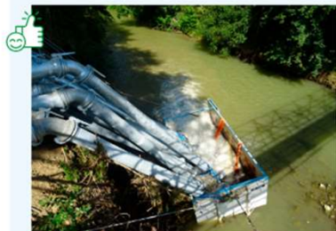
Protection du point de rejet de pompage au moyen d'une benne posée dans le lit mineur
