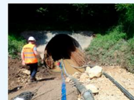
Chantier sous dérivation par pompage hors aléa climatique Crédits : Thomas Schwab / Cerema
