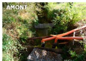
Le tronçon de cours d'eau est barré en amont par un filet et les crépines sont positionnées devant le batardeau en plaque et encore placées dans une enceinte de filet (en jaune). Crédits : GRENA Consultant
