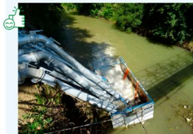
Protection du point de rejet de pompage au moyen d'une benne posée dans le lit mineur Crédits : GRENA Consultant
