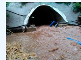
Chantier sous dérivation submergé du fait d'une capacité de pompage insuffisante face à un orage violent. Crédits : DIR Est
