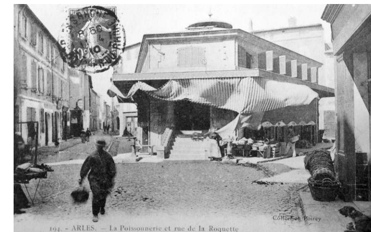
Voiles d'ombrage temporaires déployés autour de la poissonnerie à Arles
