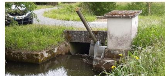
Figure 2 : exemple d'ouvrage hydraulique à rechercher aux environs de l'ouvrage
