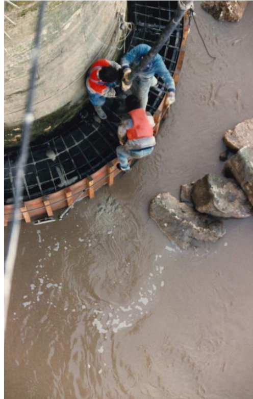
Cerclage des piles (idem)
