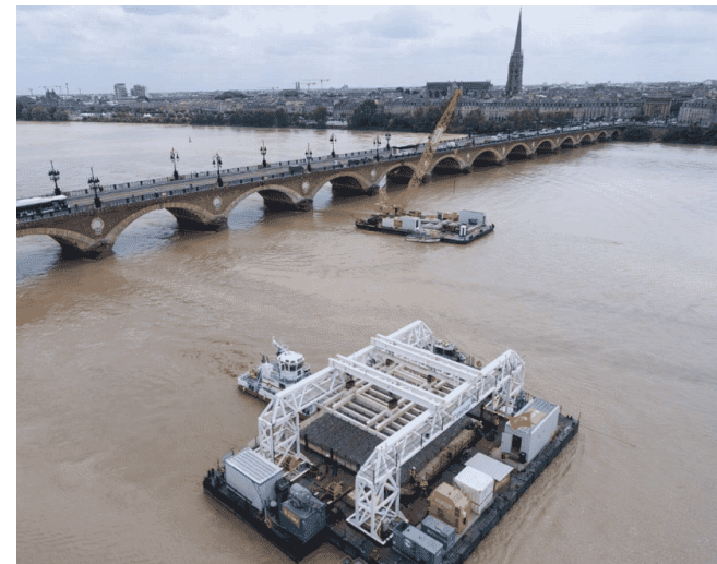
Stabilisation des talus sous- fluviaux (2017)
