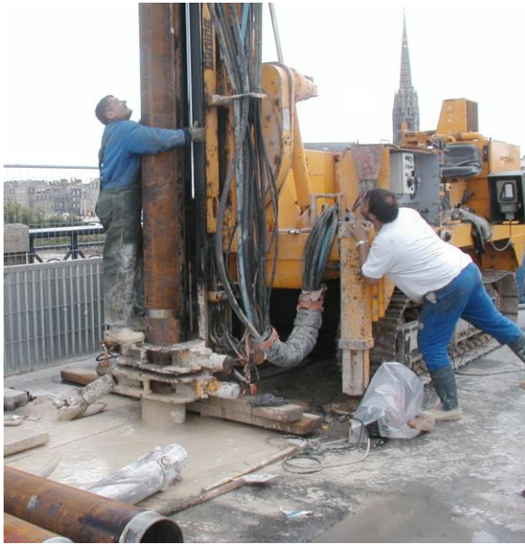
Reprise en sous-œuvre par 16 micropieux / pile P01 à P04 (1993/1994) et P05/P06 (2002)
