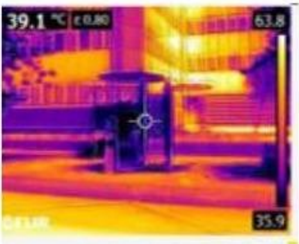
Imagerie thermique en plein soleil
