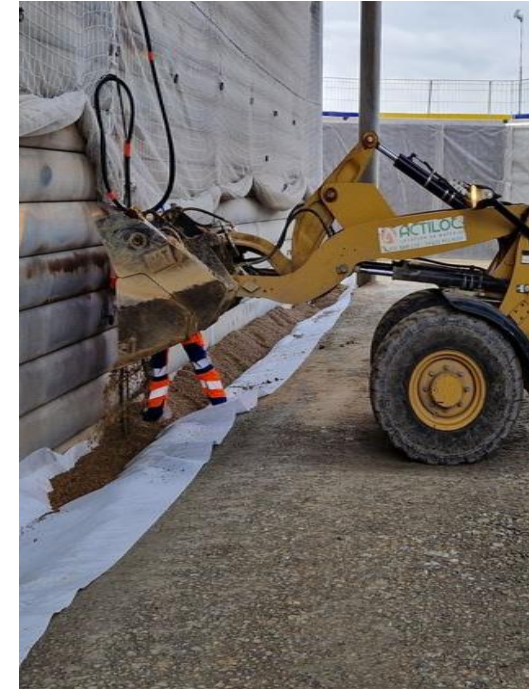
Figure 33 : Gravette roulée 4/8
