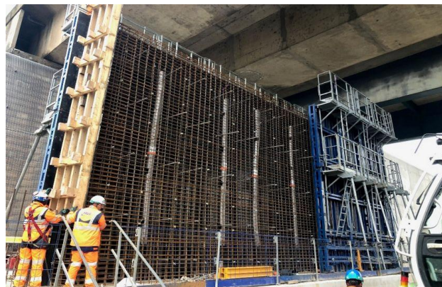
Figure 27 : Ferrailage d'un plot de voile du mur de front
