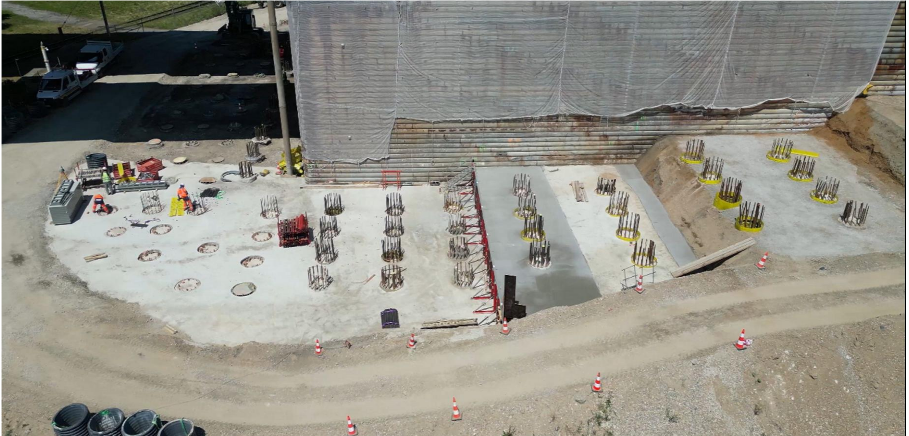
Figure 25 : Réalisation terminée des pieux côté Moselle
