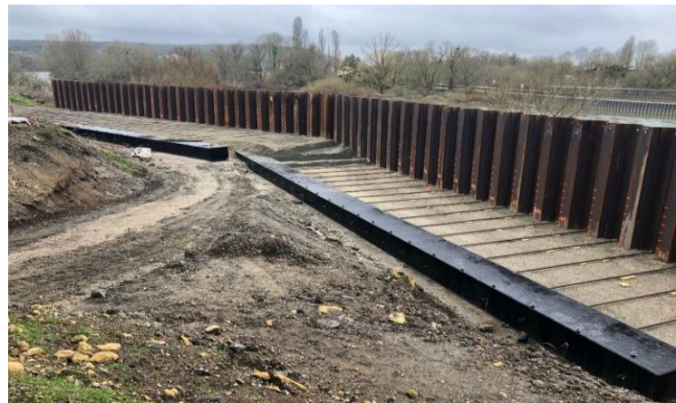
Figure 13 : Soutènement secondaire achevé
