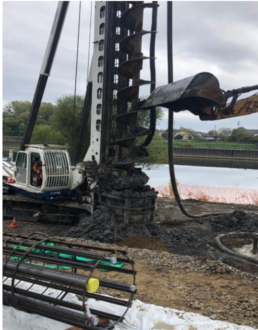
Figure 10 : Réalisation des pieux
