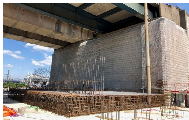
Figure 26 : Ferrailage d'un plot de semelle du mur de front
