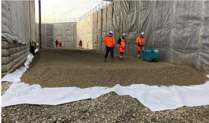
Figure 31 : 1 ère couche de remblai contigu (calcaire 0/45)
