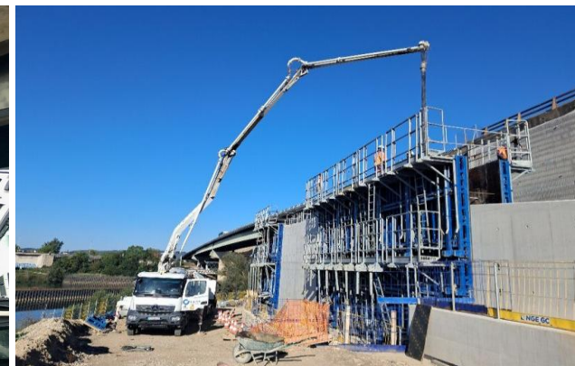
Figure 28 : Bétonnage d'un plot de voile côté Moselle
