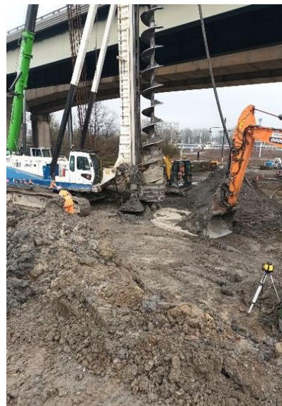
Figure 19 : Pieu bétonné
