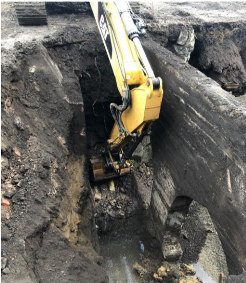
Figure 15 : Retrait à la pelle mécanique
