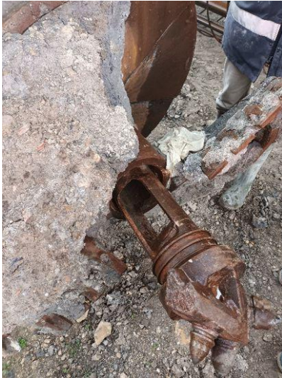
Figure 18 : Tarière creuse déployée
