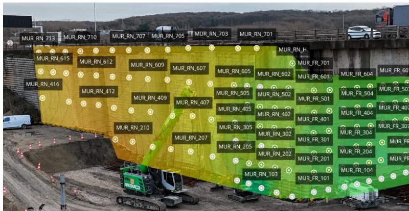
Figure 23 : Isovaleurs des déplacements selon y et z sur Beyond Monitoring
