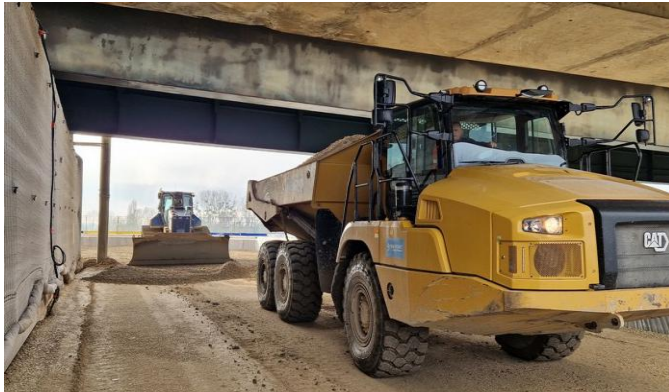
Figure 34 : Fin des remblais contigus au niveau du mur de front
