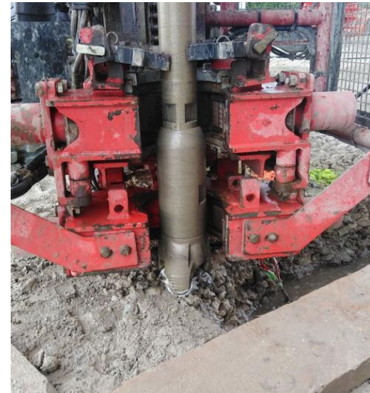
Figure 17 : Retrait à la foreuse petit diamètre
