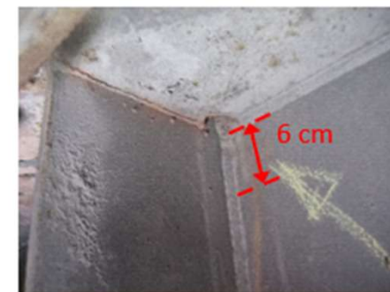
Fissure 2 : Poutre F, travée 4 (SNCF)
