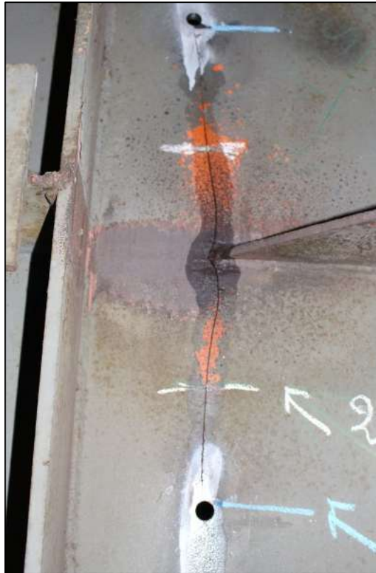
Réparation d'une fissure d'âme lors de travaux antérieurs
