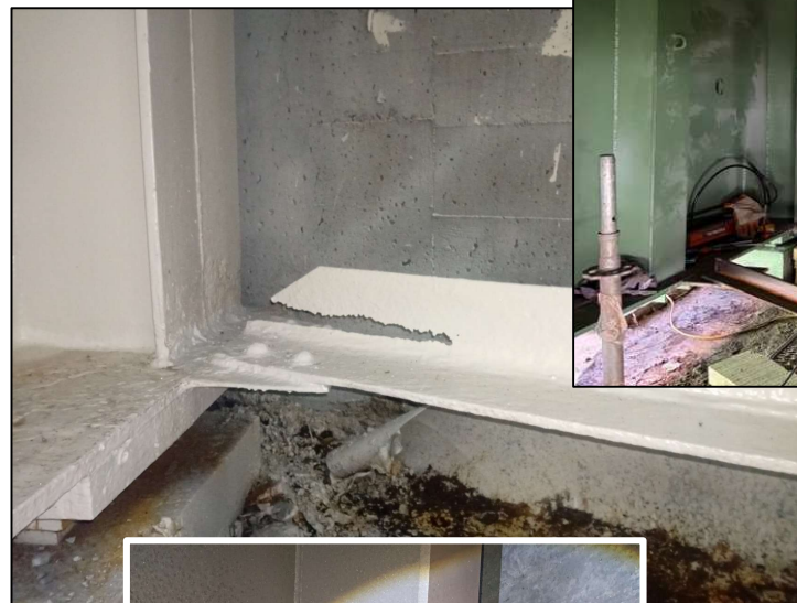
Corrosion avancée de la partie inférieure des entretoises d'appui
