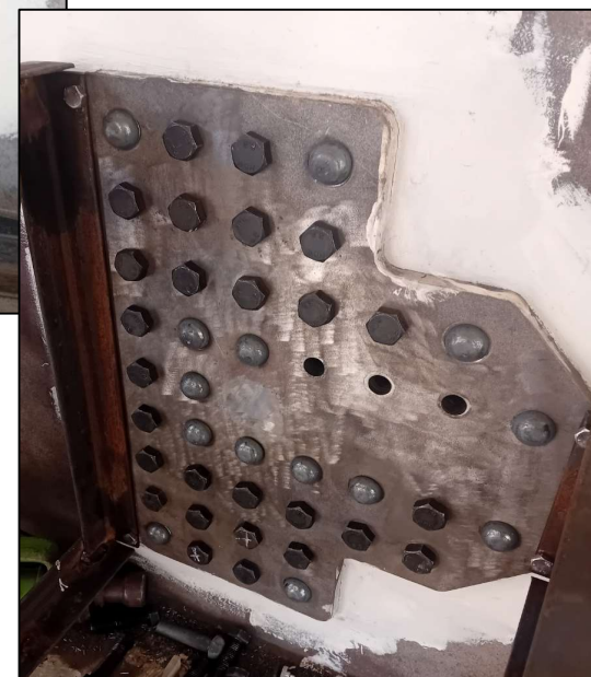
Pose des rivets à chaud 12
