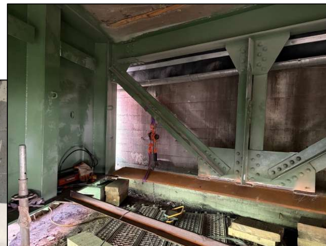
Corrosion avancée de la partie inférieure des entretoises d'appui
