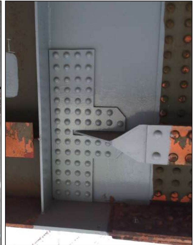
Réparation d'une fissure d'âme lors de travaux antérieurs
