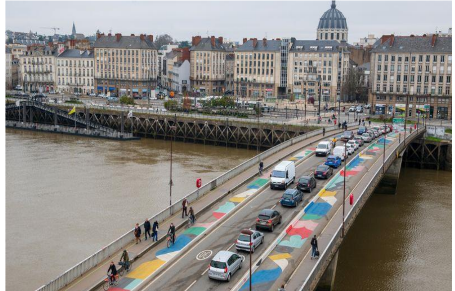
Pont Anne de Bretagne avant travaux / Source : Nantes métropole
