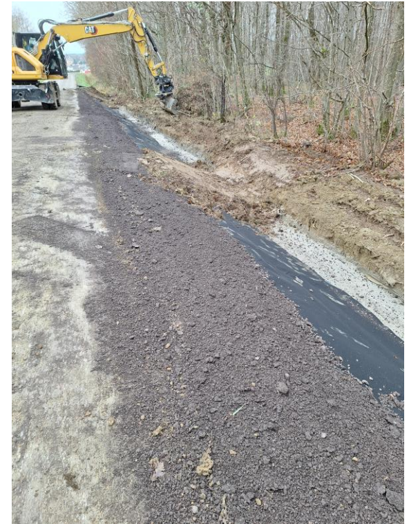
Géomembrane sur talus
