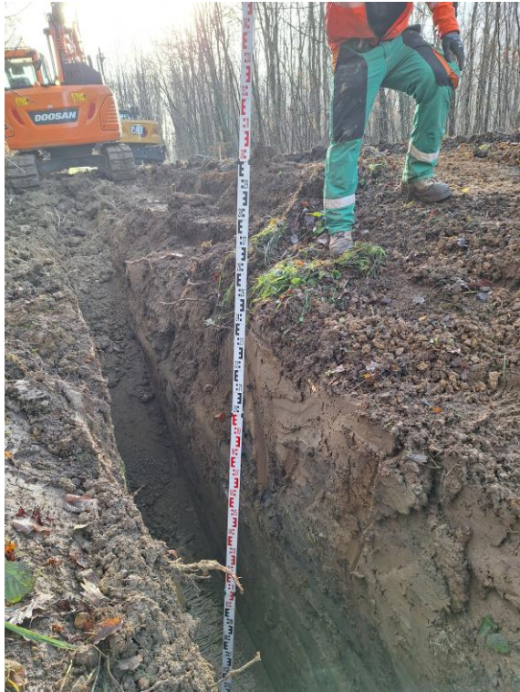
Tranchée entre chaussée et accotement
