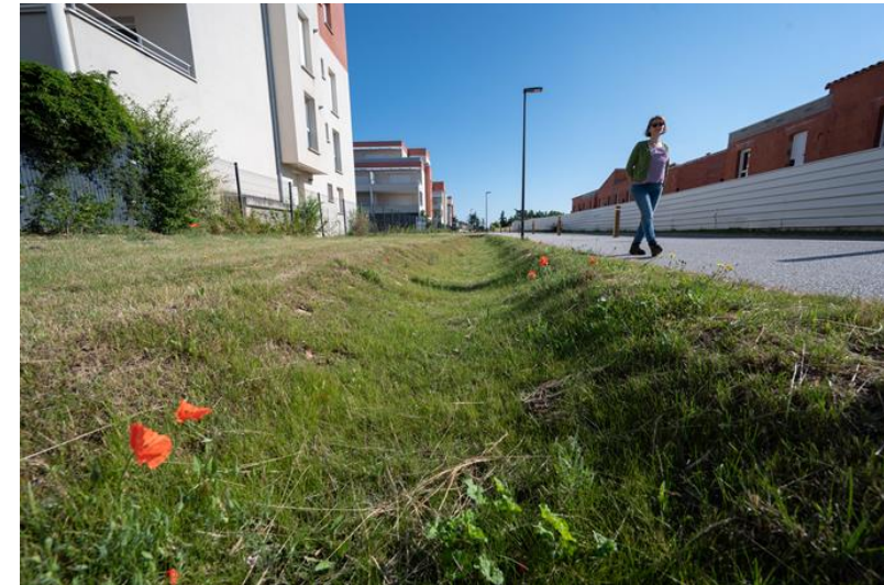
Noue à Beaumont-lès-Valence
