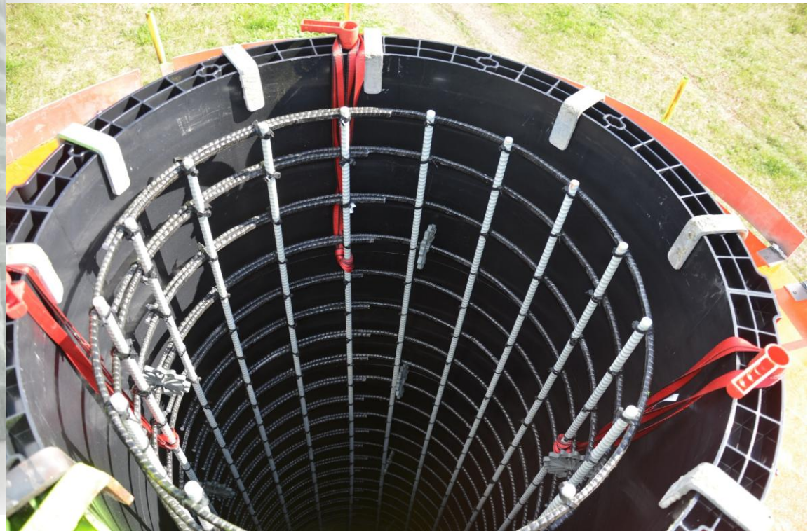
Ferrailage tourelle Men Leoneg avant coulage
