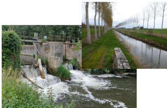
Diagnostic technique et fonctionnel des ouvrages et berges de la Dive Nord canalisée (2024-2025)
