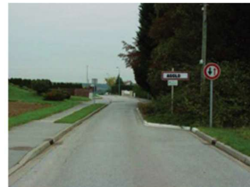
Écluse avec rétrécissement latéral
