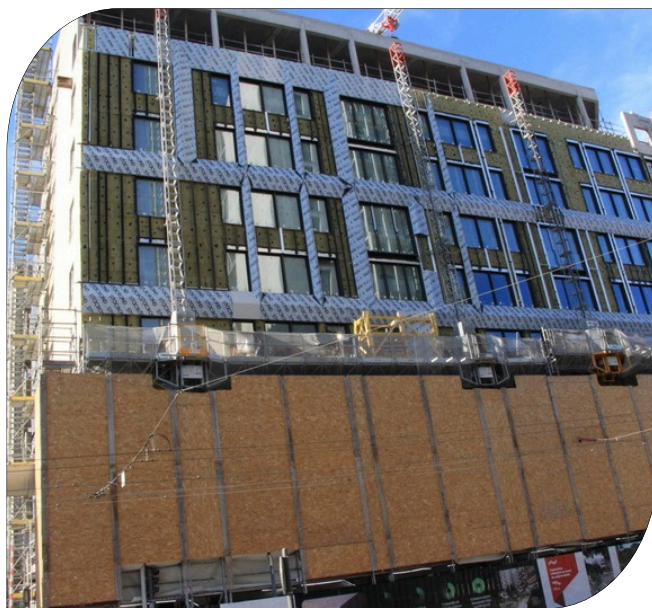
Rénovation énergétique d'un bâtiment tertiaire
