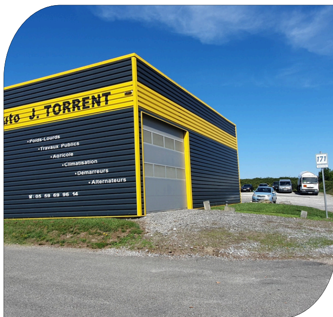
Exemple d'implantation d'entreprise en cœur de parcelle, ZAE des Soarns, Lacq-Orthez, Crédit photo Cerema, 2023
