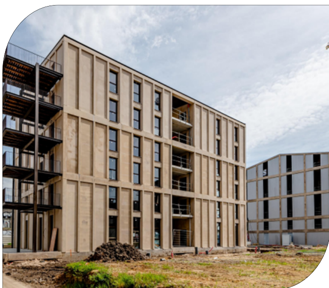
Exemple de verticalité du bâti. Phase d'achèvement du chantier, Bordeaux Brazza. Crédit Agricole Immobilier, 2024 https://www.cerema.fr/fr/system/files?file=documents/2024/04/diaporama_volumes_capables.pdf
