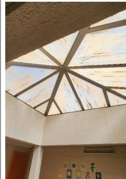
Photo : « Blanc de Meudon » idéal pour protéger temporairement une surface vitrée complexe, mais non résistant à la pluie (© Cerema)
