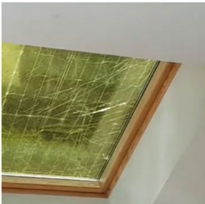
Photo : couverture de survie appliquée sur une fenêtre de toit (© Cerema)
