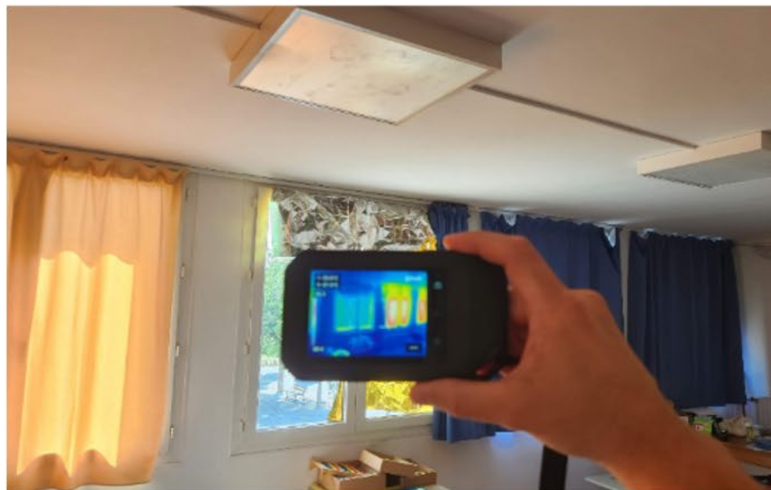
Photo : efficacité d'une couverture de survie en protection temporaire VS rideaux intérieurs, vue à la caméra thermique (© Cerema)
