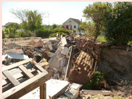
Mouvements de terrains (avalanches, affaissement, ...)
