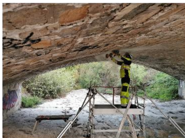
Figure 8. Capteurs autonomes, connectés et dynamiques et capteurs fibres optiques distribués (CFOD) développés dans le projet SURVOUT. Crédits photo SURVOUT.
