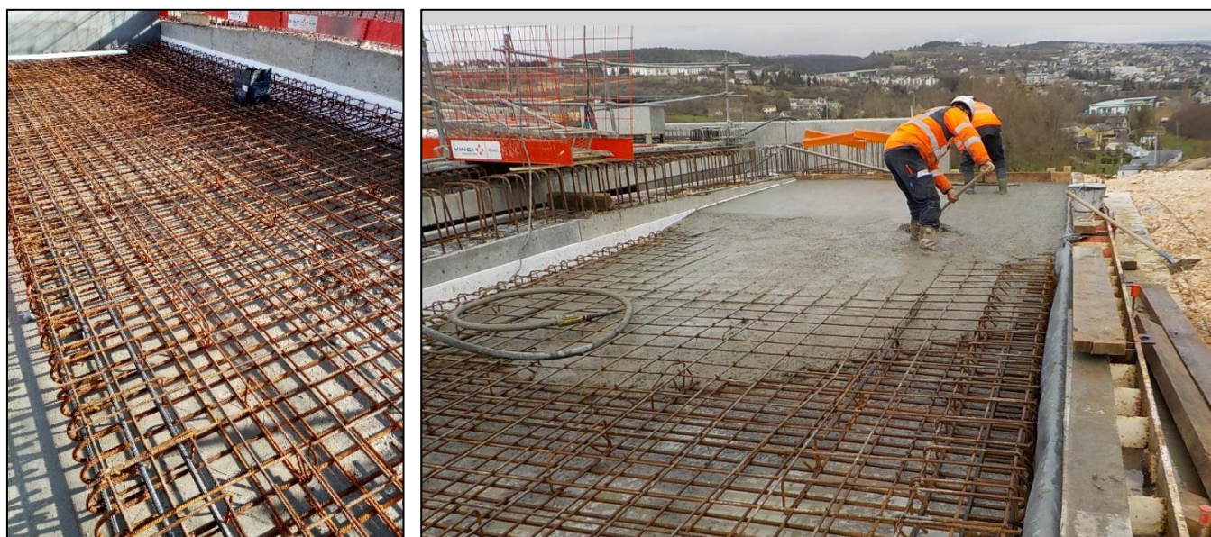
Figure 8 : Ferrailage et bétonnage de la dalle de transition du viaduc du Lot à Mende (crédits DIR Med) : on peut voir la poutre de chaînage en extrémité de dalle sur la photo de gauche, ferrillée selon les pratiques antérieures
