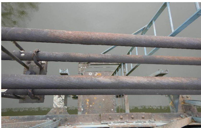
Figure 61 : enrrouillement des câbles porteurs [photo setec diadès]
