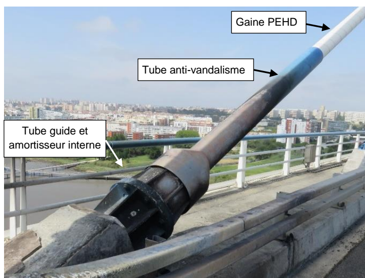
Figure n°7 : illustration des éléments constitutif d'un hauban
