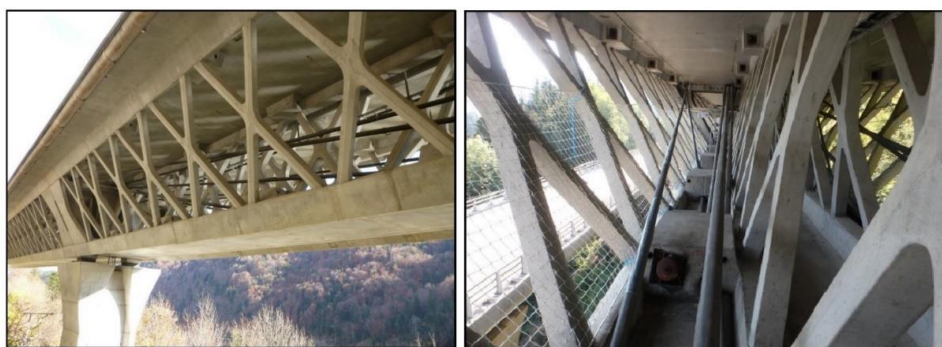
Figure 31 Vue du caisson ouvert du viaduc de Sylans et sa précontrainte
