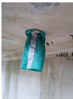
FIGURE 85. Dispositif anti-retour pour les chiroptères
