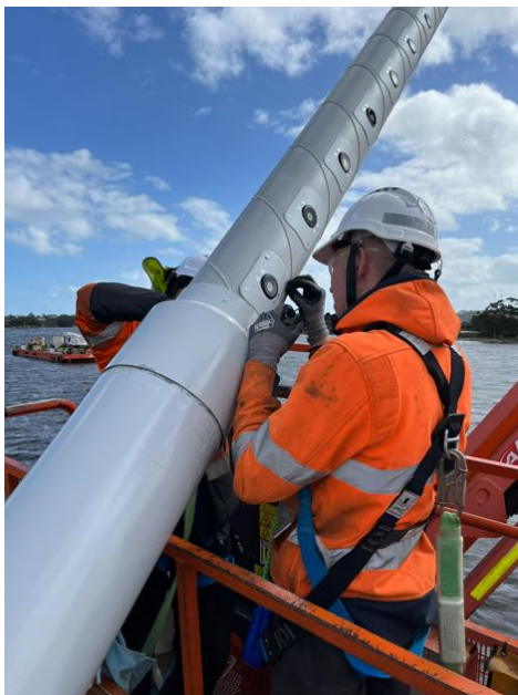
Figure 11 Installation des gaines équipées de LEDs
