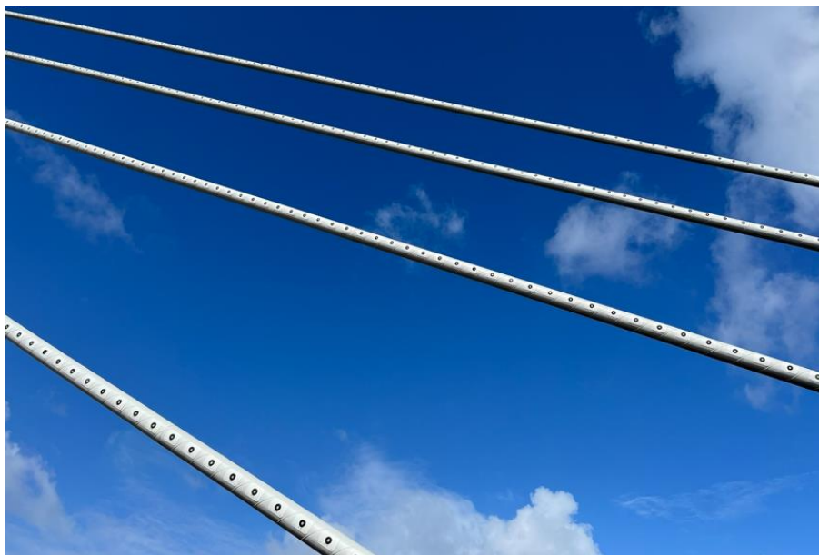
Figure 16 Densité de LED sur les haubans, 1 / 30 cm
