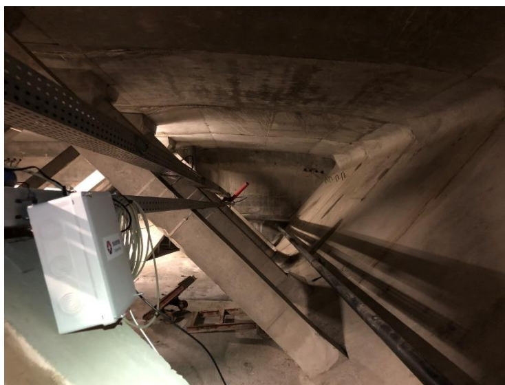
Figure n°8 : vue du câble associé, dans sa branche d'extrémité côté culée, à l'intérieur du caisson
