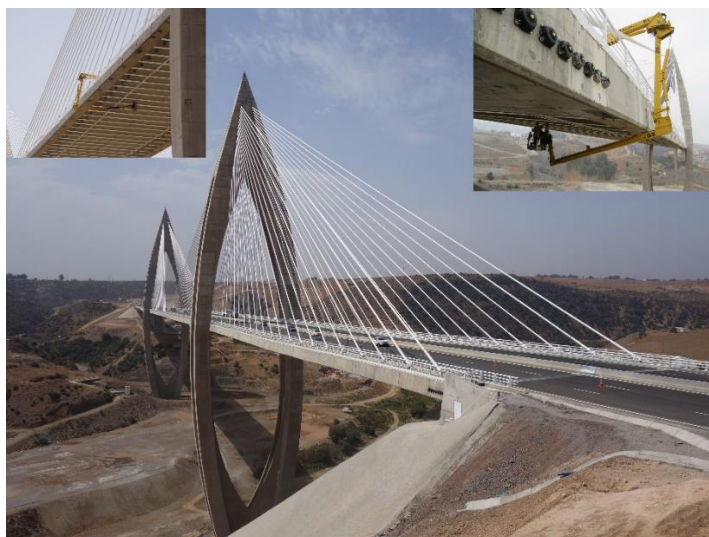
Figure 8 : Nacelle négative entre les haubans du pont Mohammed VI – ©setec diadès
