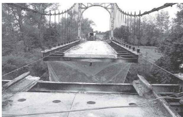
Figure 59 : Déconstruction du tablier lors de la démolition du pont du gué de Sénac
