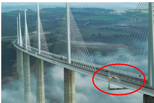
Figure 6 : Passerelle négative sous le viaduc de Millau - ©setec diadès
