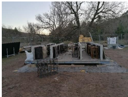
FIGURE 90. Aire de préfabrication des blochets
