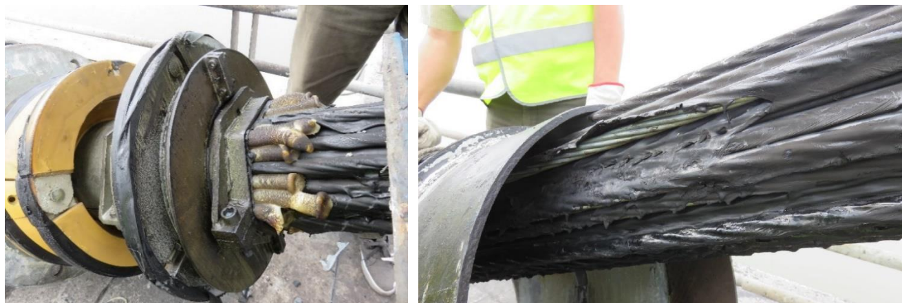
Figure n°5 : endommagement de l'amortisseur et des gaines individuelles PEHD (partiellement fondues)
