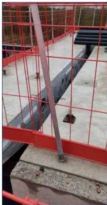
Figure 50: Liaseal assemblés sur voussoir préfabriqué
