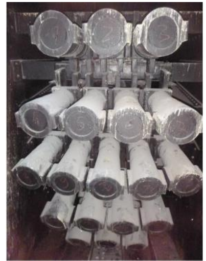
Figure 75 : Vue des culots d'ancrage des haubans
