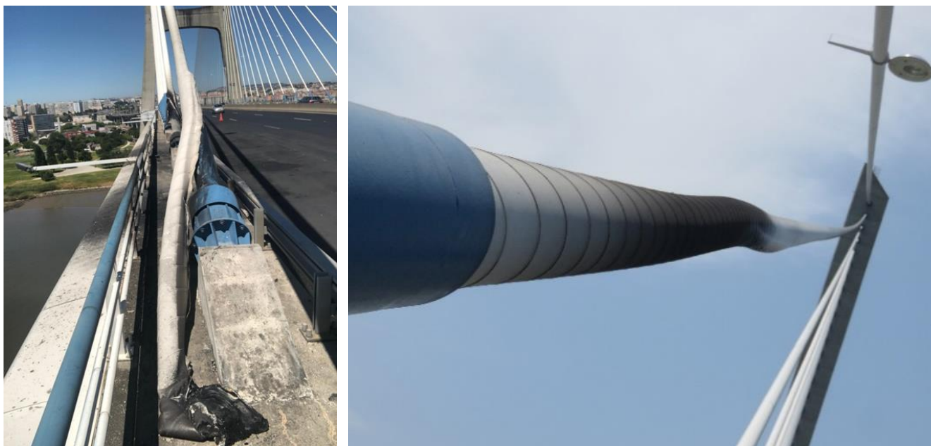
Figure n°4 : gaine PEHD partiellement fondue sur le hauban n°22 (photo de gauche) et gaine PEHD déformée sur le hauban n°23 (photo de droite)
