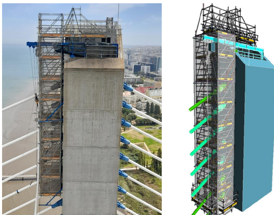
Figure n°11 : échafaudage d'accès aux haubans (hauteur total 18 m)
