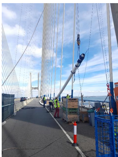
Figure n°14 : levage d'une gaine (à gauche) et ancrage réglable démonté dans le pylône (à droite)
