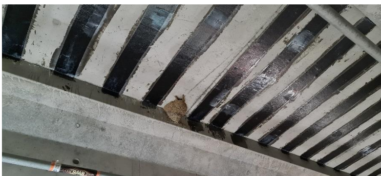
FIGURE 87. Calepinage des renforts composites collés en fonction des nids d'hirondelles rousselines
