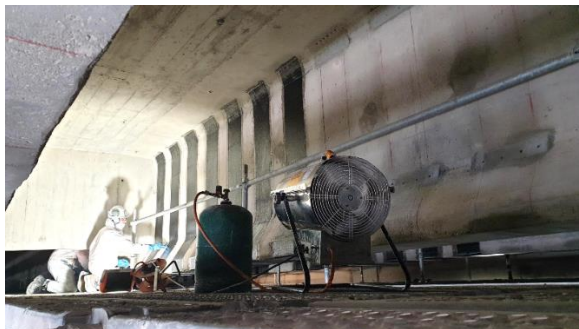
FIGURE 89. Pose des renforts composites avec chauffage d'appoint
