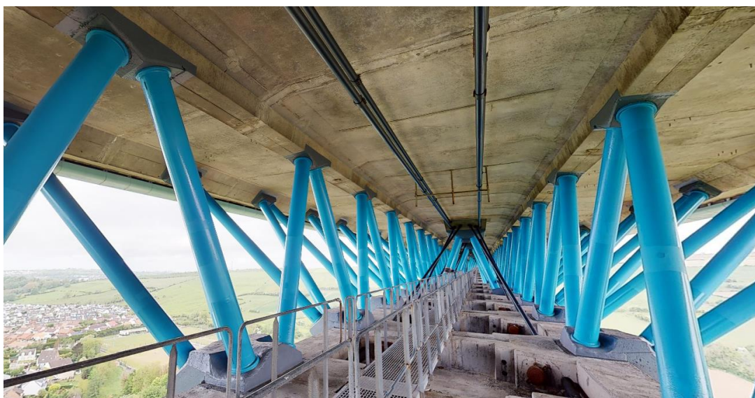
Figure n°4 : Viaduc d'Echinghen – Vue des câbles droits démontés en intrados de hourdis
