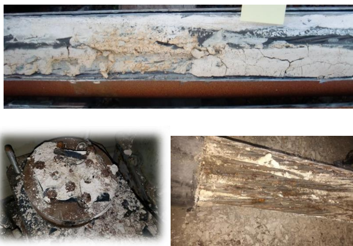
Figure n°11 : Exemples de défauts de remplissage et formation de pâte blanche sur câble rempli de coulis de ciment
