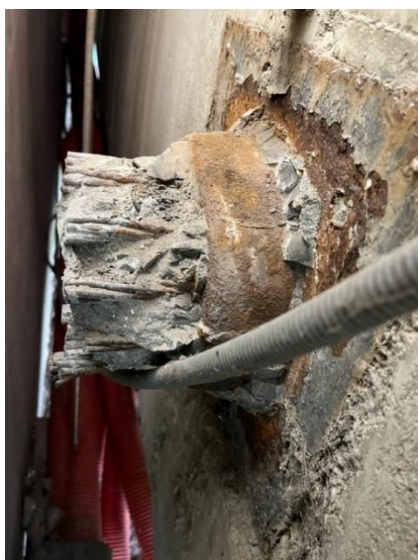
Figure n°7 : vue d'une tête d'ancrage dégradée par corrosion
