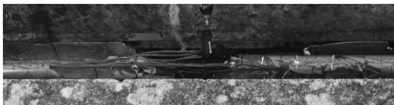
Figure n°17 : Opération d'injection puis découpe de toron sur câble 45m de longueur
