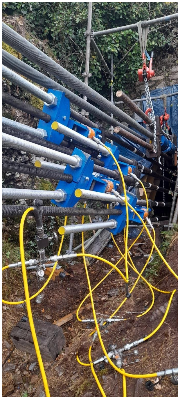
Figure 7 : Sortie des chambres d'ancrages avec suspension provisoire et existante lors du transfert de charge - Vérinage des câbles de retenue existants – Crédit photo Baudin Chateauneuf
