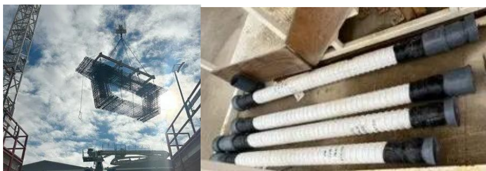
Figure 54: Préfabrication de la cage de ferrailage et du gainage de précontrainte intérieur
