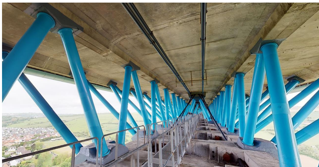
Figure n°2 : Viaduc d'Echinghen – Vue des câbles droits démontés en intrados de hourdis
