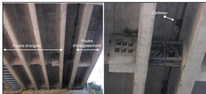
FIGURE 83. Travée de rive élargie avec zoom sur une entretoise métallique de liaison et des corbeaux métalliques d'appui
