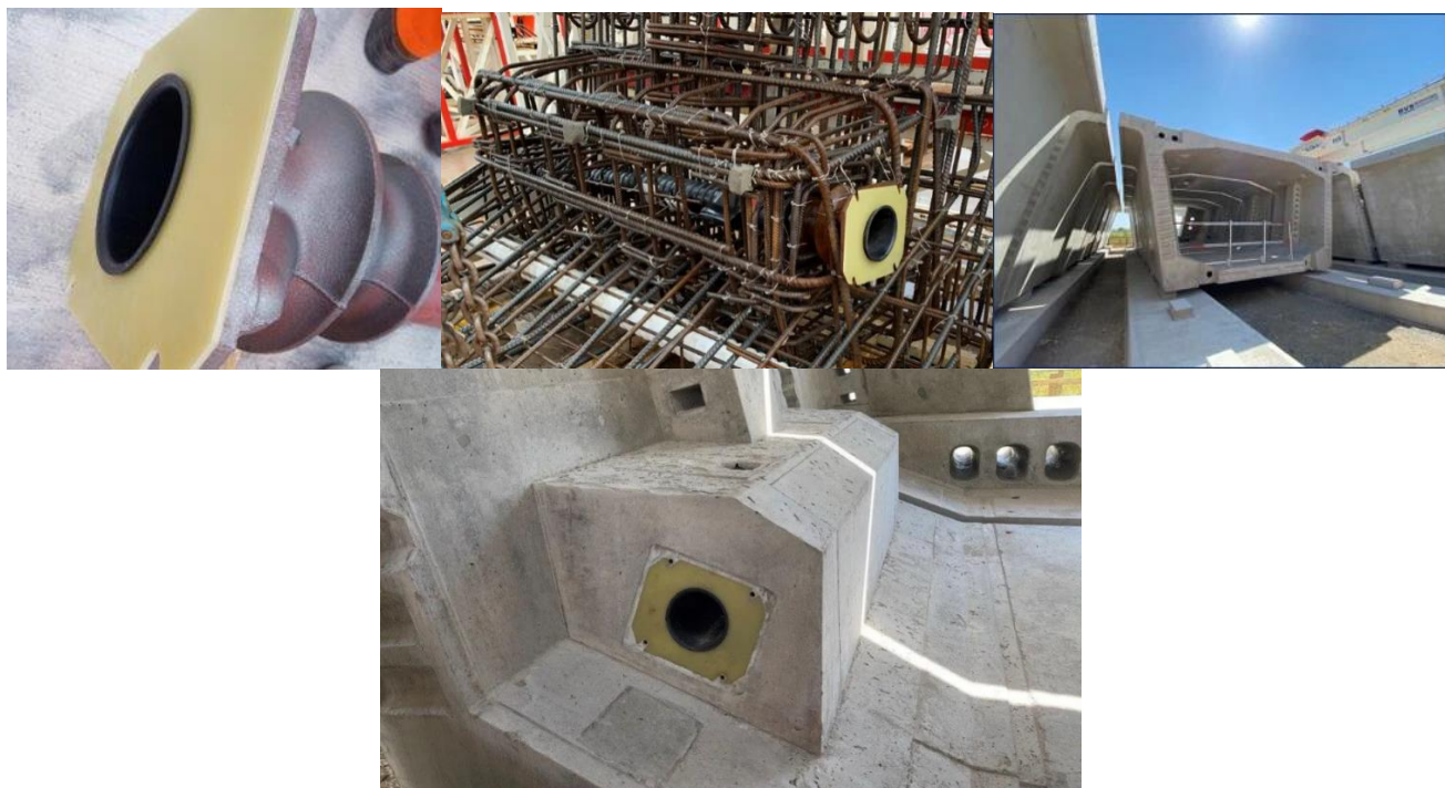
Figure 48 : Ancrage de précontrainte isolée électriquement du projet HS2
