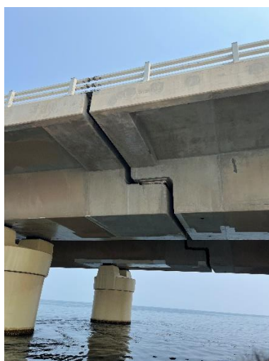
Figure n° 7 : Joint cantilever entre travée cantilever et travée suspendue
