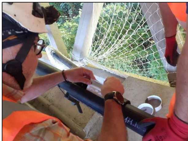
Figure n°6 : Installation d'un capteur RFID sur le viaduc de Sylans en Septembre 2022
