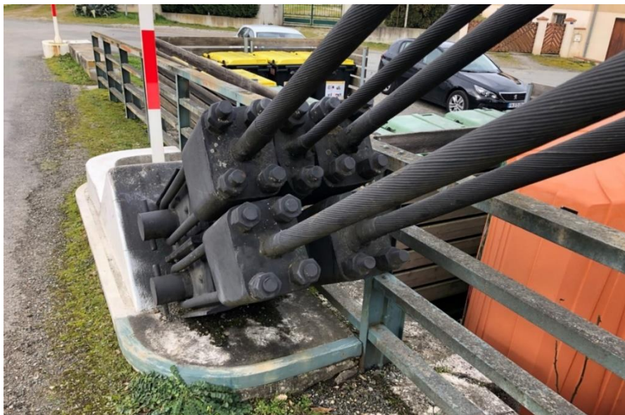
Figure 56 : Ancrages des câbles de retenue sur massifs [photo setec diadès]
