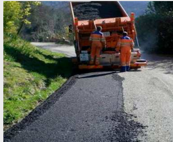
Reprofilage de la chaussée. (chaud ou tiède)
