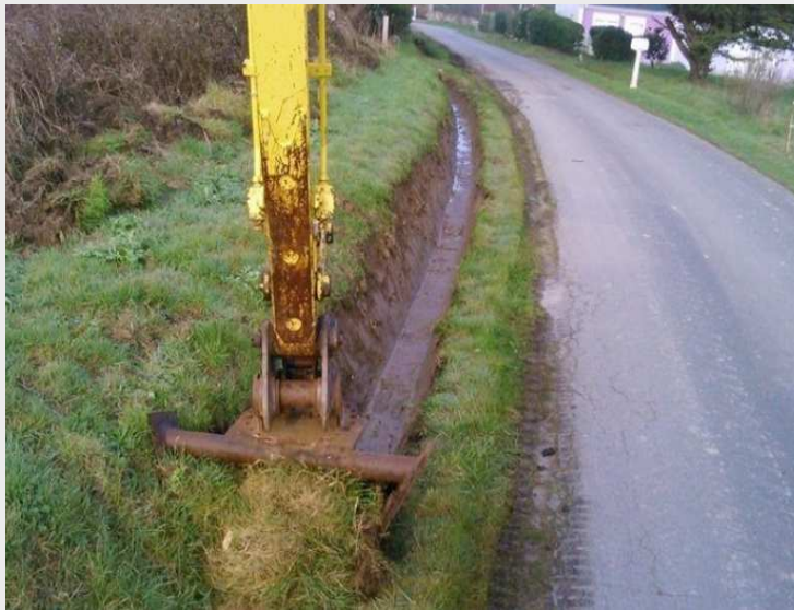
Curage fossés et dérasement des accotements.
