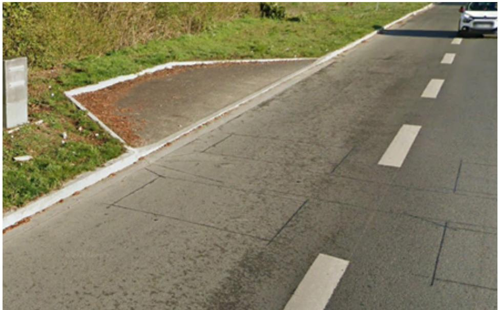
Le système de recueil des données routières SIREDO (capteurs et stations de mesure du trafic) a été mis en place depuis de nombreuses années afin d'améliorer et standardiser la production et le recueil des données de trafic sur le réseau routier national, ainsi que sur les réseaux routiers structurants interurbains des collectivités (départements, métropoles).
