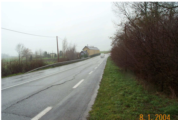
Figure 18 : Photographie d'un remblai situé sur la RN158 à Macé (61) dont les désordres (fissurations et tassements) se sont aggravés suite à l'été 2003. Source : Cerema, DTerNC.
