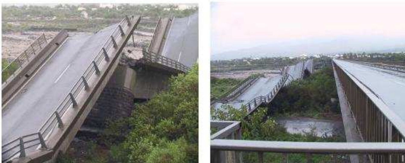
Figure 21 : Photographies d'un pont situé sur la rivière Saint-Étienne à la Réunion qui s'est effondré le 26 février 2007 lors du passage du cyclone Gamède sur la Réunion : ce phénomène s'est accompagné de fortes précipitations qui ont provoqué l'affouillement de certaines piles et la chute successive de plusieurs travées. Source : DDE La Réunion.
