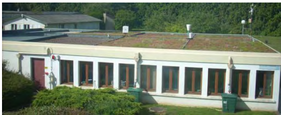
Toiture végétalisée du CETE IdF à Trappes.
