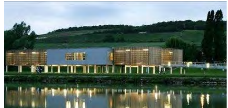
Gymnase nautique de Château-Thierry, Aisne, conçu sur pilotis afin de respecter les plus hautes crues connues de la Marne. Architecte Eric Pace.
