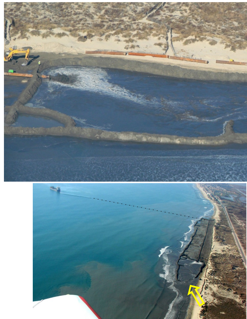
Figure 59 : Refoulement de sable par une drague hydraulique dans des casiers de ressuyage
