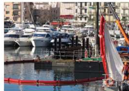
Figure 46 : Exemples de mise en œuvre d'écrans anti-turbidité au cours de travaux maritimes
