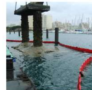
Figure 46 : Exemples de mise en œuvre d'écrans anti-turbidité au cours de travaux maritimes
