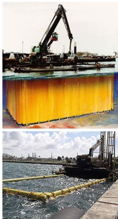
Figure 49 : Différents cas d'implantation d'un écran anti-turbidité pour isoler la zone à draguer
