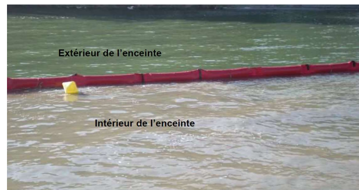
Figure 109 : Utilisation opérationnelle d'un écran anti-turbidité dans l'étang de Berre
