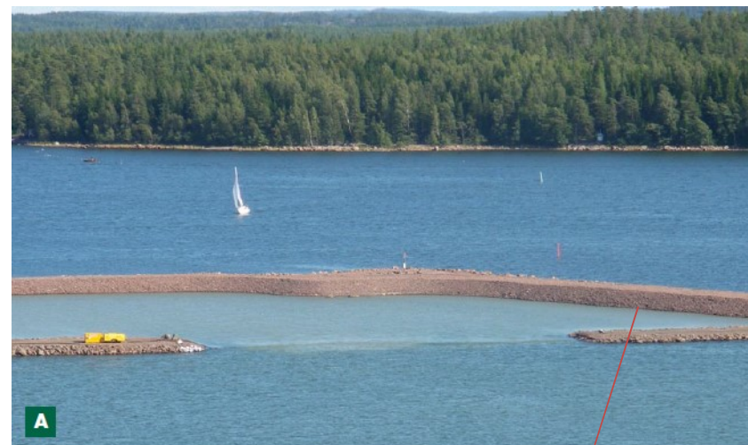
Figure 53 : Utilisation d'un rideau de bulles pour confiner un bassin portuaire en Finlande
