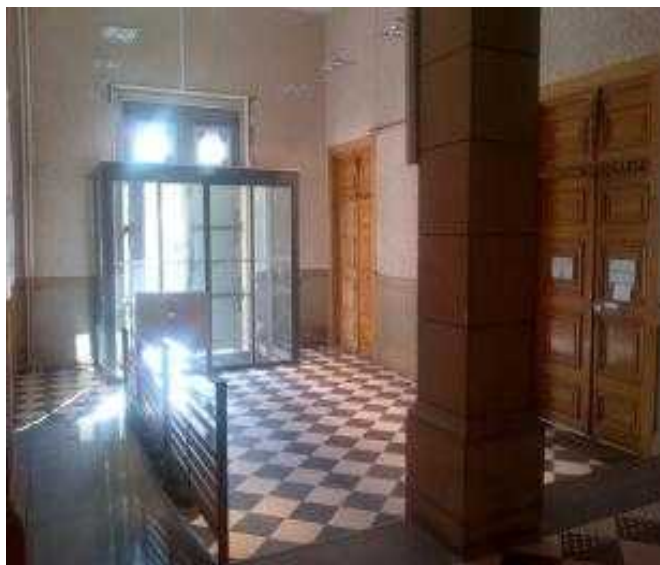
Rampe pour cheminement intérieur SAS motorisé Renforcement éclairage
