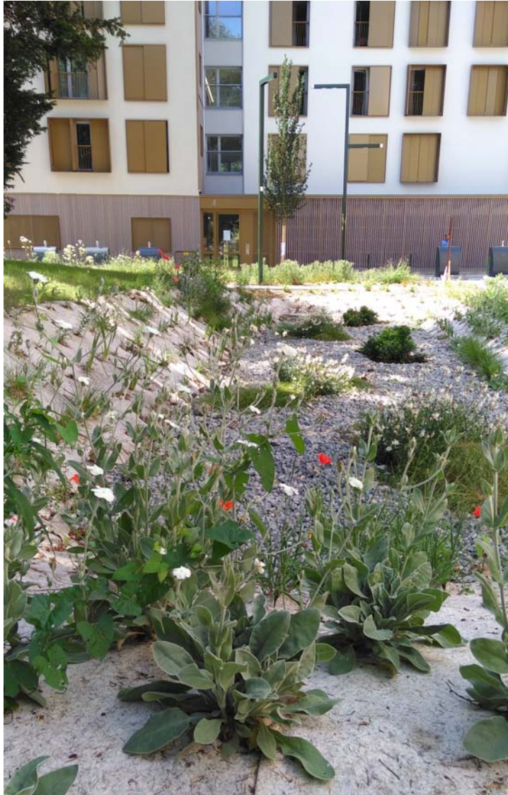
les noues du parc Ilan Halimi - fond de noue en béton recyclé + îlots plantés
