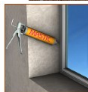
Amélioration de l'étanchéité
