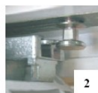
(1) Armature en acier, (2) Gâche métallique avec galet champignon, (3) Paumelle anti-dégondage
