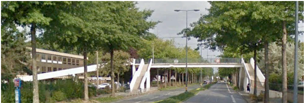
Passerelle pour les piétons et bandes cyclables étroites, avenue de Lattre de Tassigny à Angers
