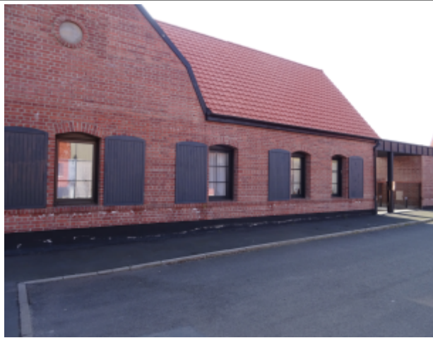
Villeneuve d'Ascq – une ancienne ferme rénovée
