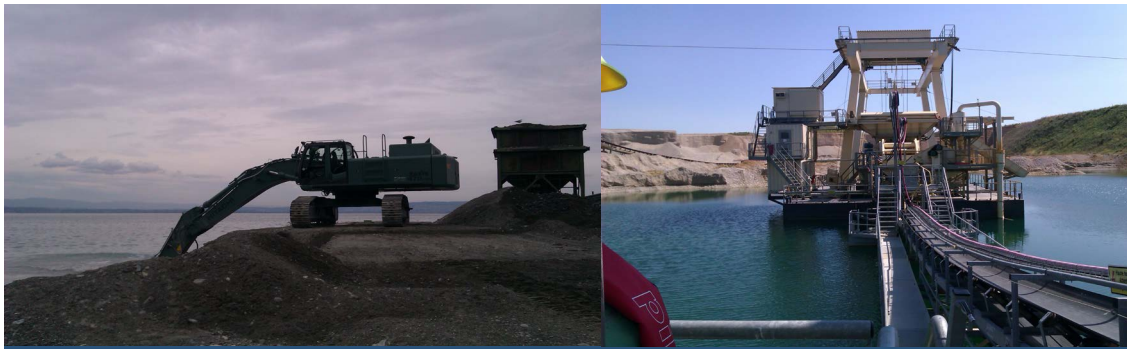
Dragage des matériaux
