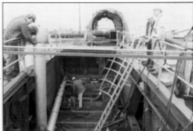
Le clavage - Réalisation du platelage inférieur.
