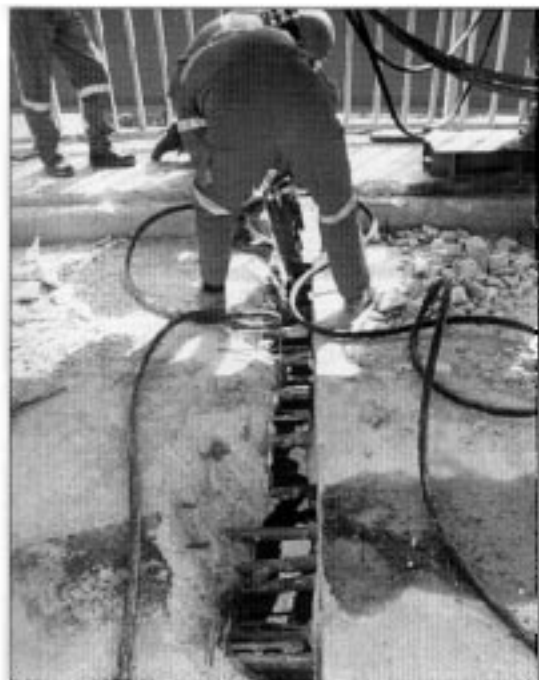
Figure 10 : élargissement du trait de sole au marteau piqueur pour accéder aux armatures.
