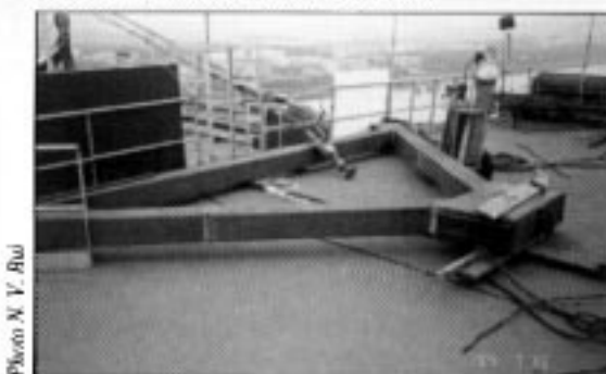
Triangle de clavage sur le voussoir Nord.
