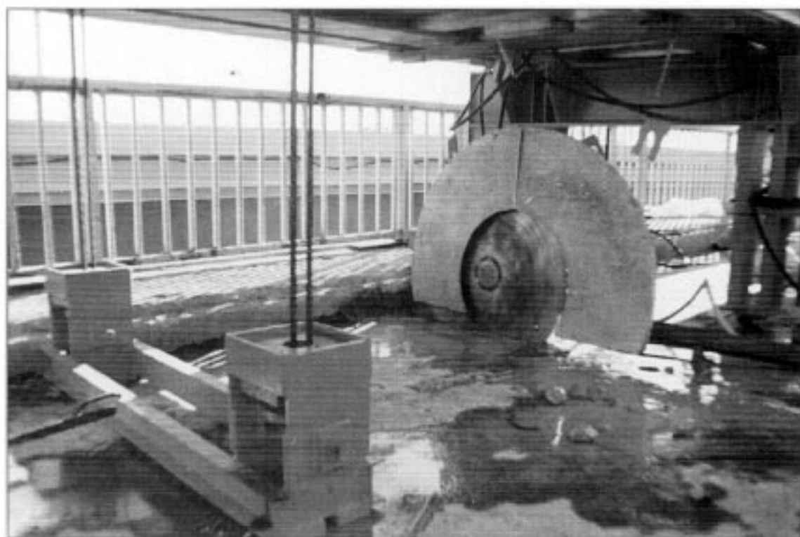
Figure 4 : sciage transversal du hourdis.
