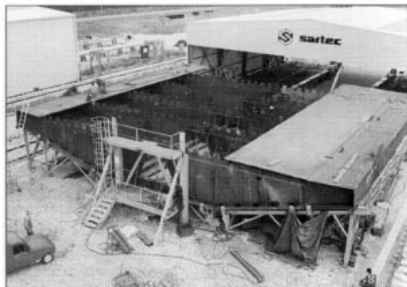
Assemblage d'un voussoir.
