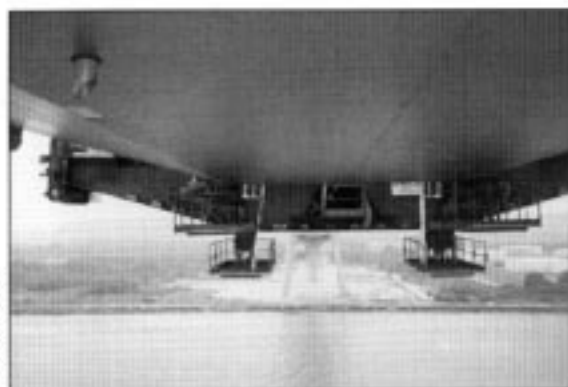
Vue de l'extrémité d'un fléau. À noter la position basse du voussoir côté Nord due à une mise en tension partielle de ses haubans, qui permet, dans cette position, de bien distinguer les appareils de clavage (entretoises cylindriques et triangles).
