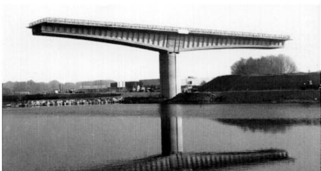
Fin de construction du fléau sur pile P6.
