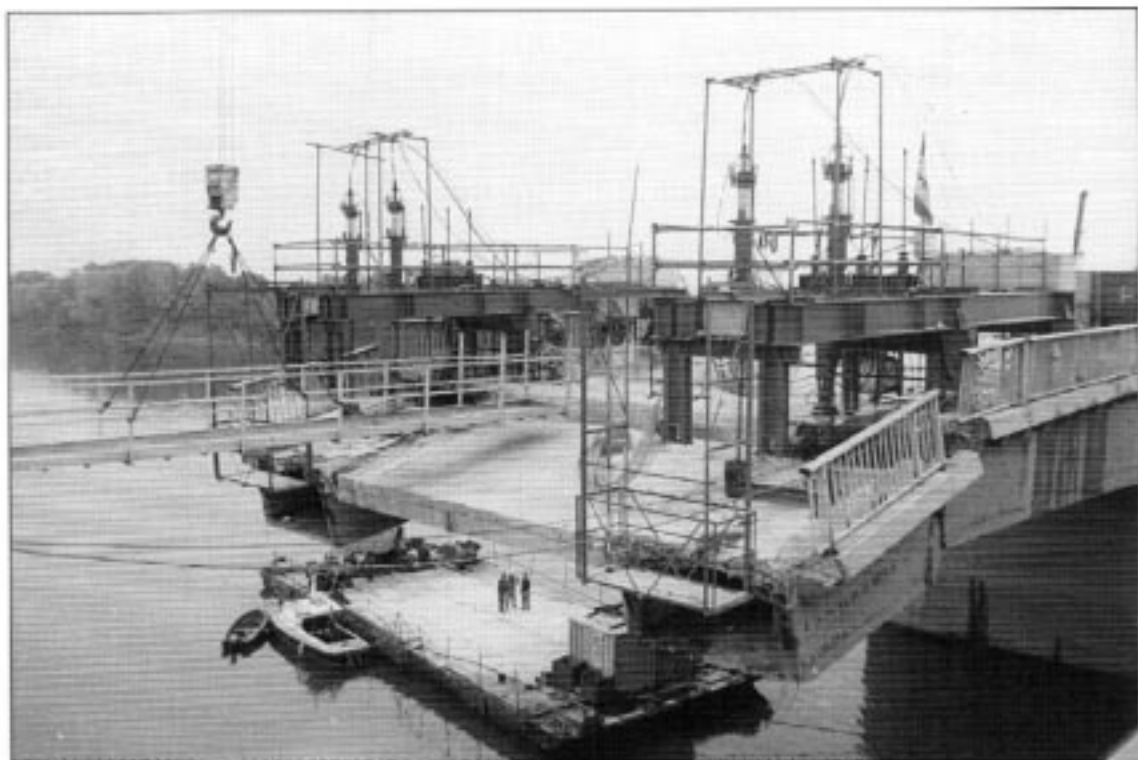
Figure 6: désolidarisation d'un voussoir.
